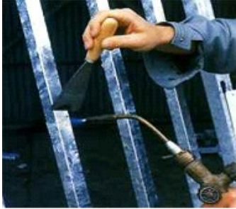
Abb. 1: Tropfnasen können durch vorsichtiges Aufschmelzen des Zinküberzuges und Abbürste des verflüssigten Zinks mittels einer Drahtbürste oder Entfernen mit einem Metallspachtel beseitigt werden.
