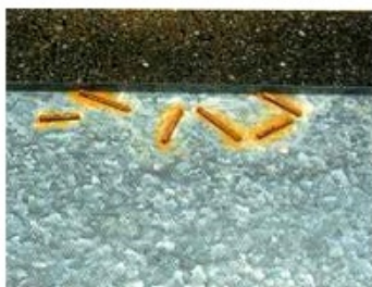
Abb. 4: Reste von Schweißelektroden können sog. "Fremdrost" verursachen
