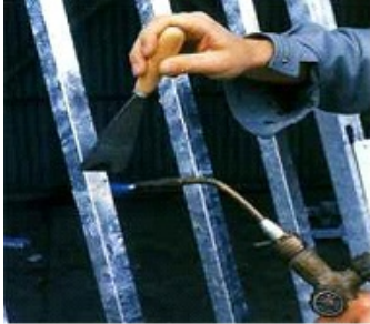
Abb. 1: Tropfnasen können durch vorsichtiges Aufschmelzen des Zinküberzuges und Abbürste des verflüssigten Zinks mittels einer Drahtbürste oder Entfernen mit einem Metallspachtel beseitigt werden.
