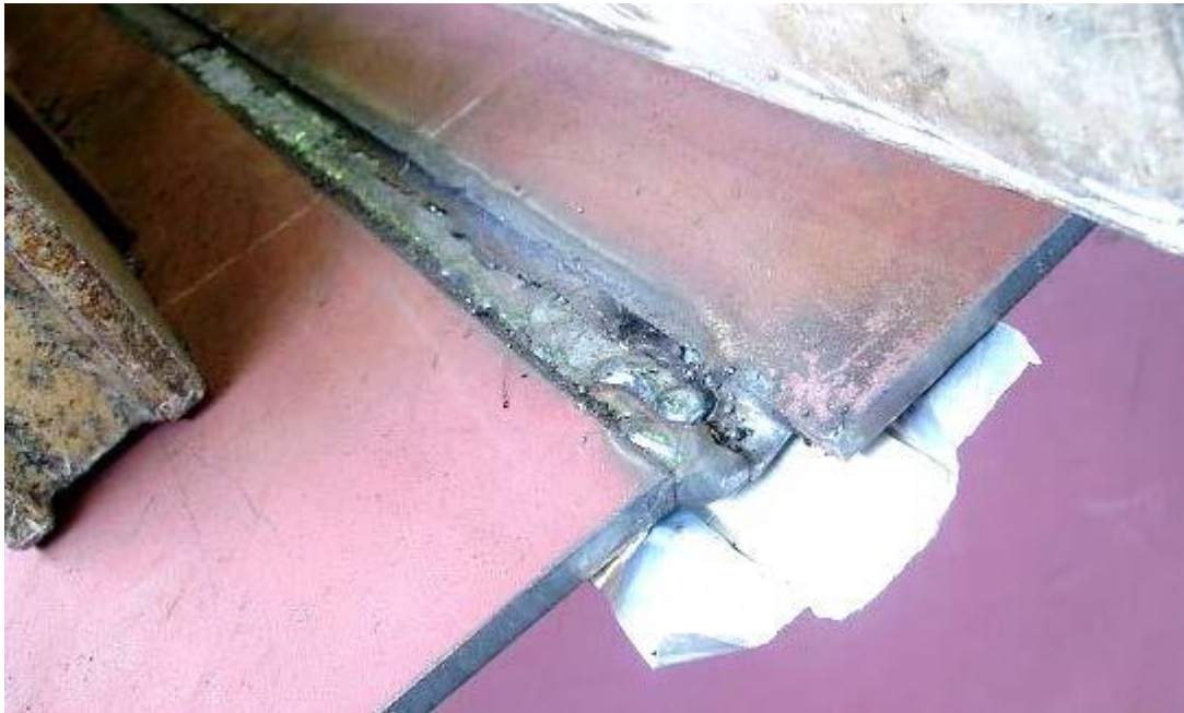
Bild 4. Sichtprüfung während des Schweißens, Riss in Zwischenlage
