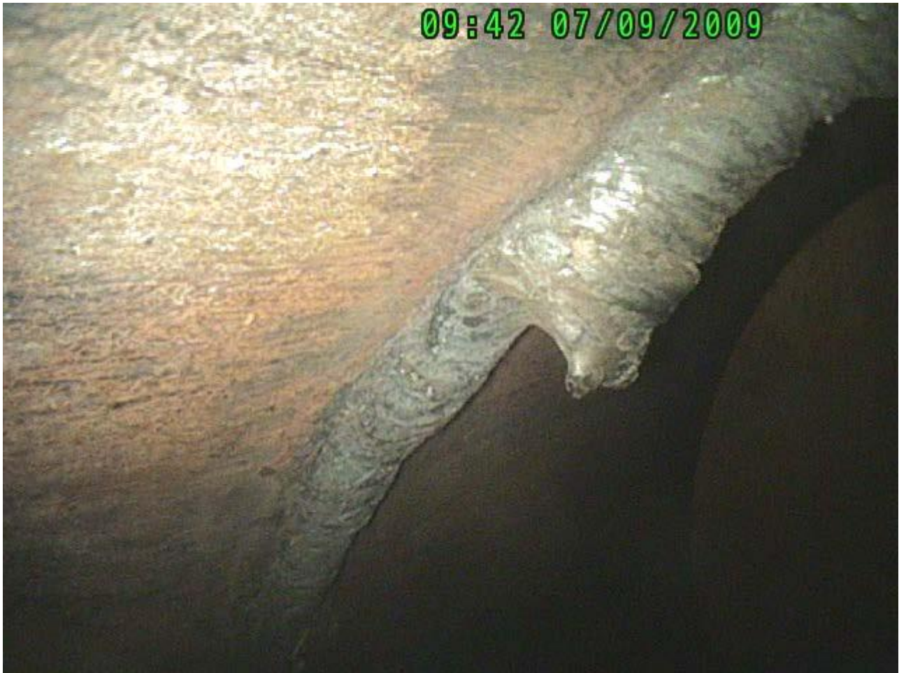
Bild 16. Schweißgutüberlauf
