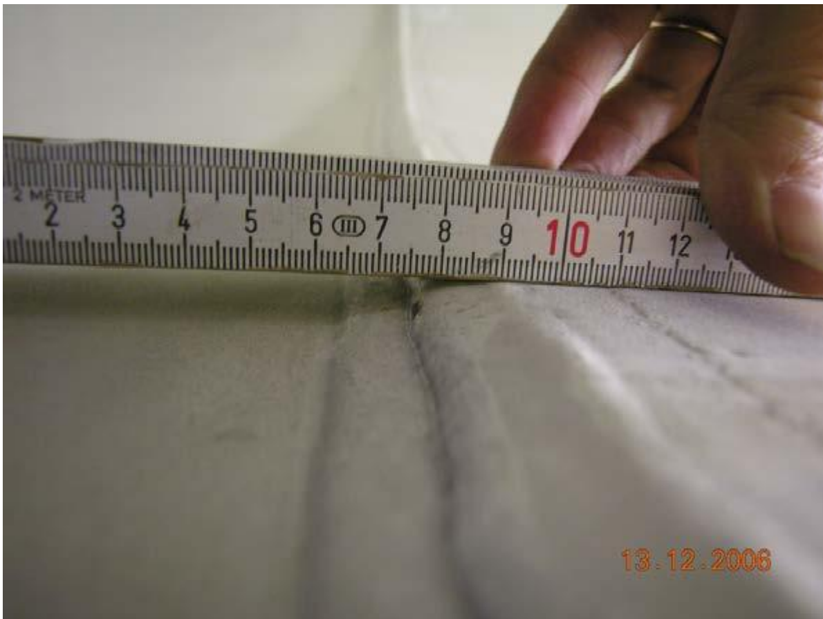
Bild 19. Kantenversatz
