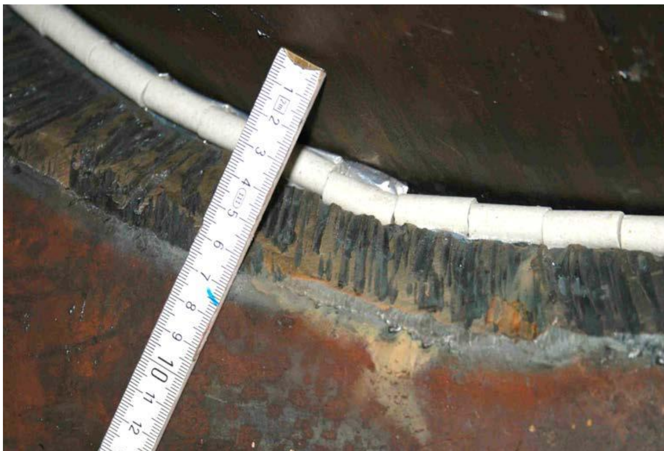
Bild 2: Nahtvorbereitung mangelhaft
