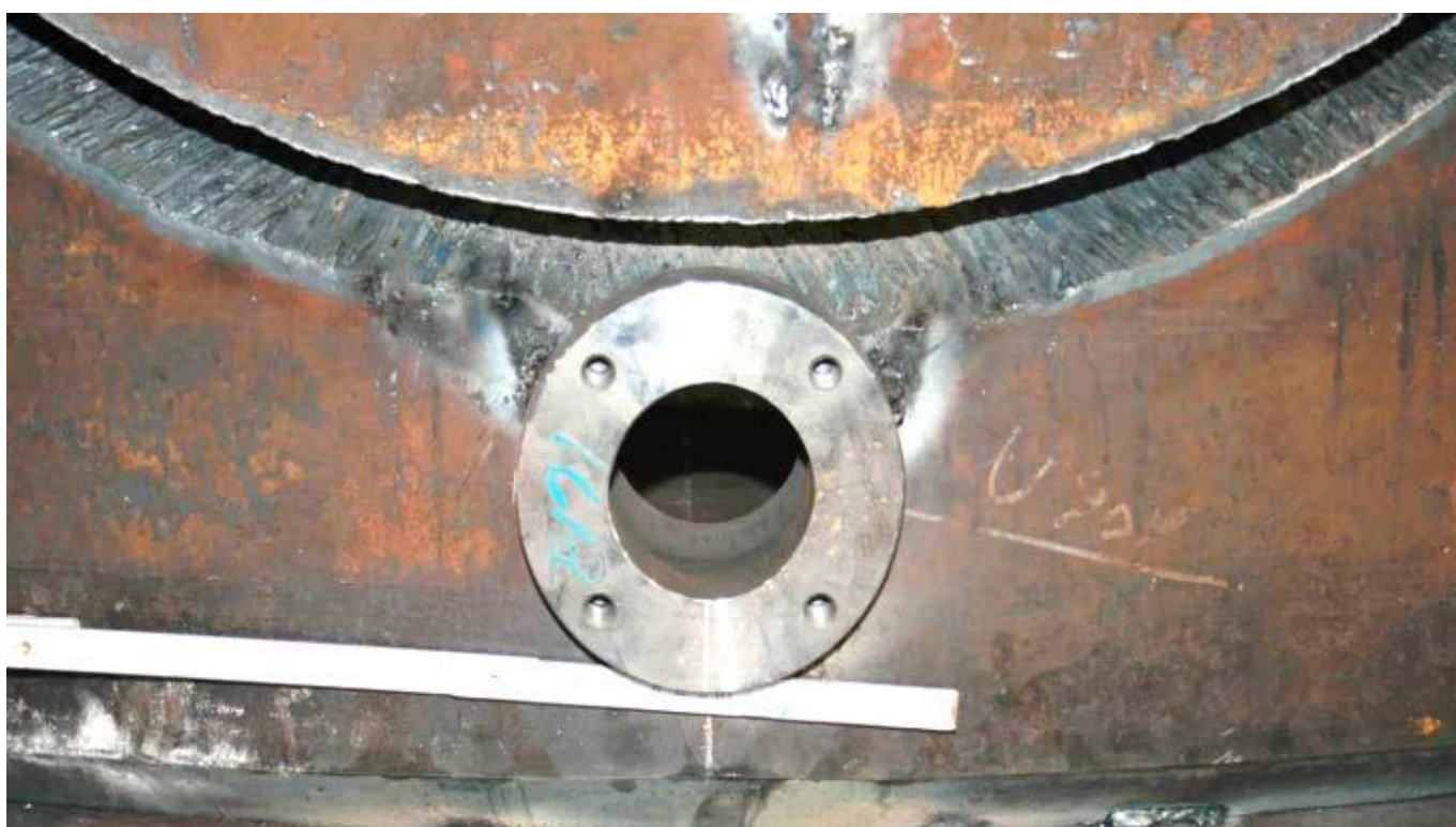
Bild 3: Nahtvorbereitung mangelhaft, Schweiß- und Zusammenbaufolge nicht beachtet.
