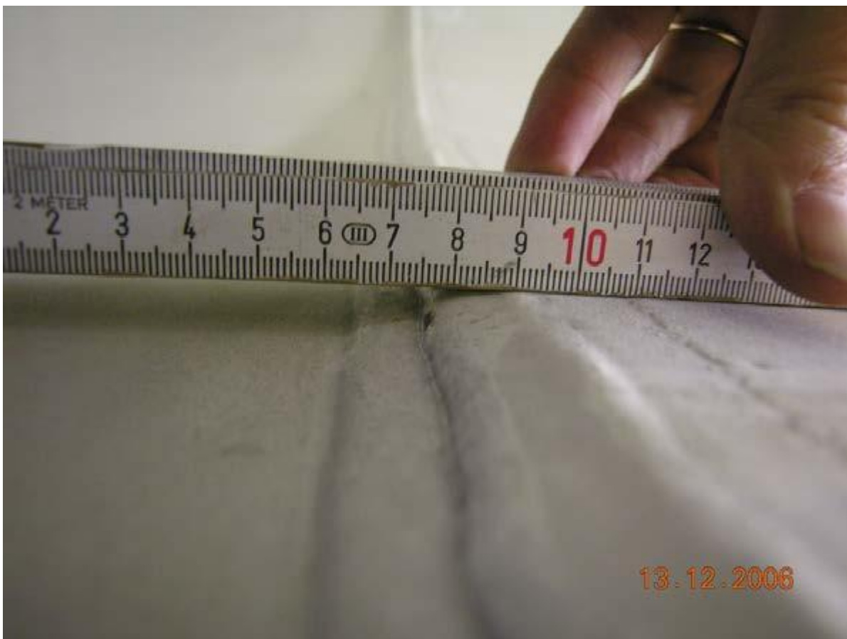
Bild 19. Kantenversatz
