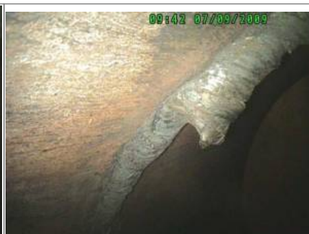
Bild 16: Schweißgutüberlauf
