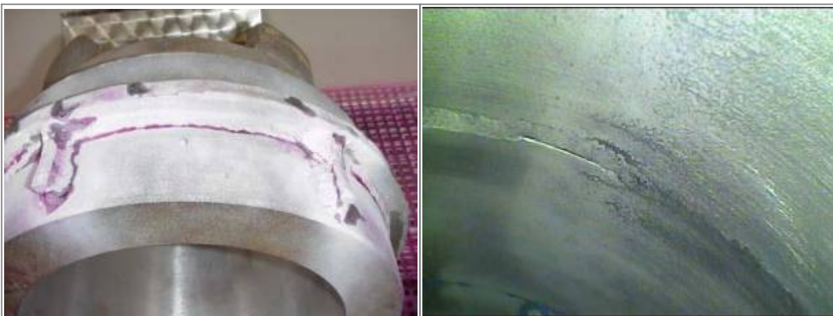
Bild 12. Bindefehler zur Oberfläche hin offen
