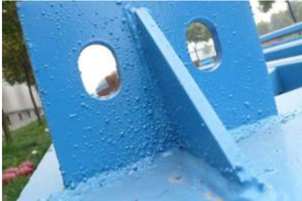
Bild 21: Schweißspritzer
