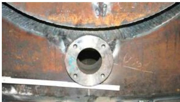
Bild 2: Nahtvorbereitung mangelhaft..... Bild 3: Nahtvorbereitung mangelhaft,
