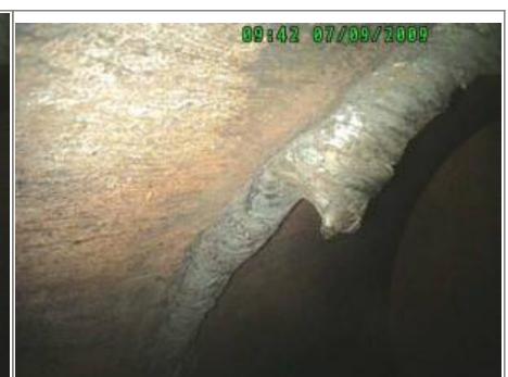
Bild 16: Schweißgutüberlauf
