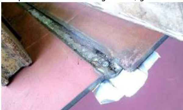
Bild 4: Sichtprüfung während des Schweißens, Riss in
