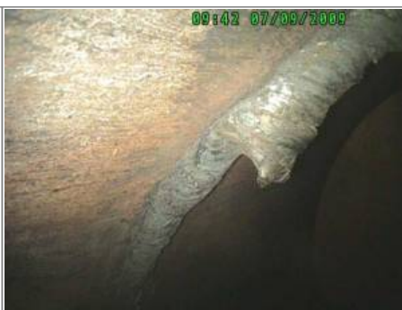
Bild 15: Wurzelüberhöhung
