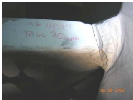
Bild 5: Gerissene Schweißkonstruktion
