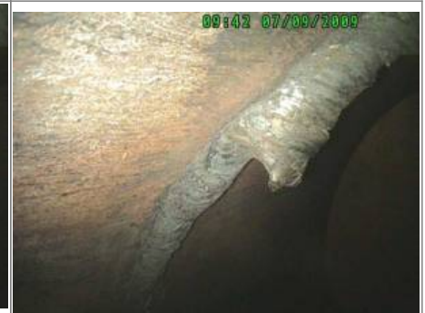
Bild 16: Schweißgutüberlauf
