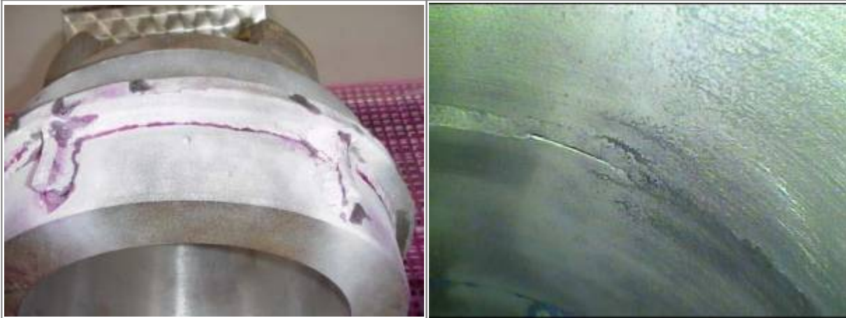
Bild 12. Bindefehler zur Oberfläche hin offen
