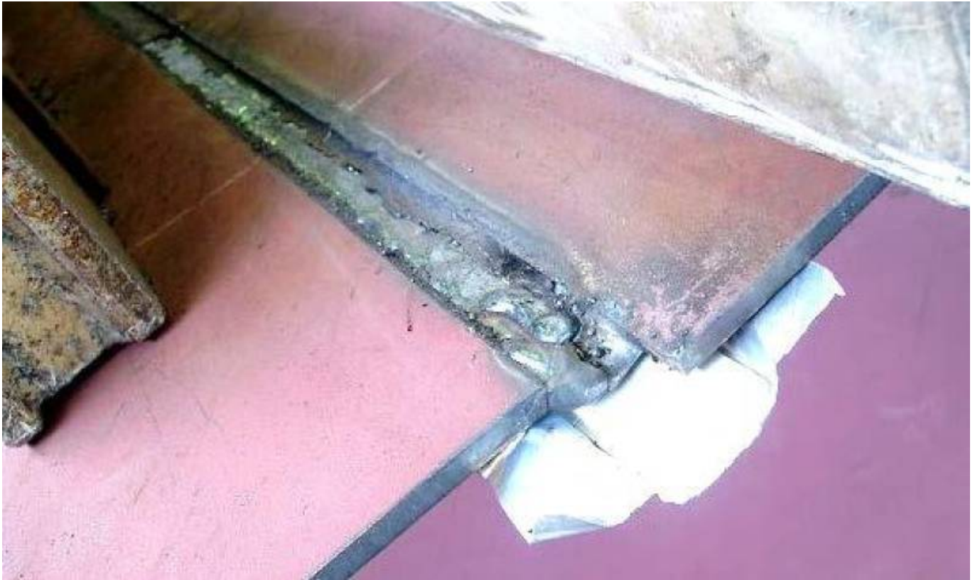
Bild 4: Sichtprüfung während des Schweißens, Riss in Zwischenlage
