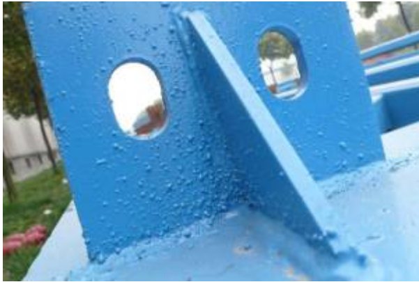
Bild 21: Schweißspritzer
