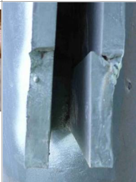
Bild 20: Kantenversatz
