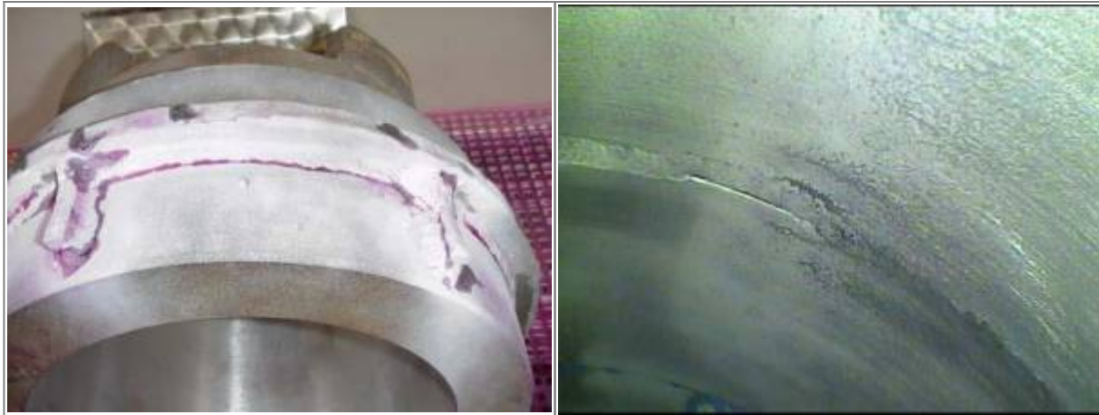
Bild 12. Bindefehler zur Oberfläche hin offen
